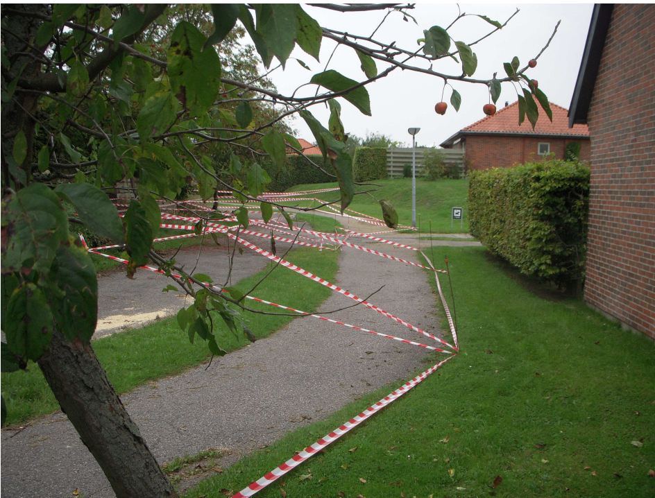
Den nye skråning set fra øst mod vest, hvor Strandgårdsvejs huse i ét plan ligger i næsten samme niveau som Bakken
