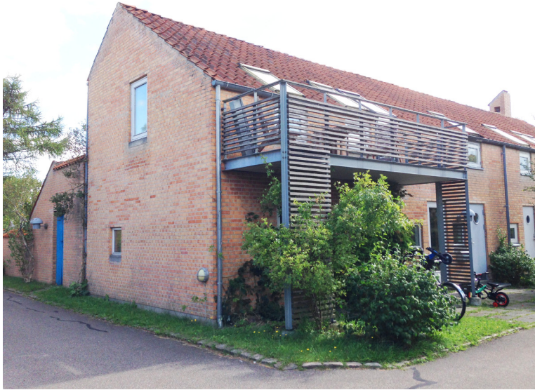
Det er altanen på hus 18, som danner forbillede for fremtidige altanfornyelser på Bakken
